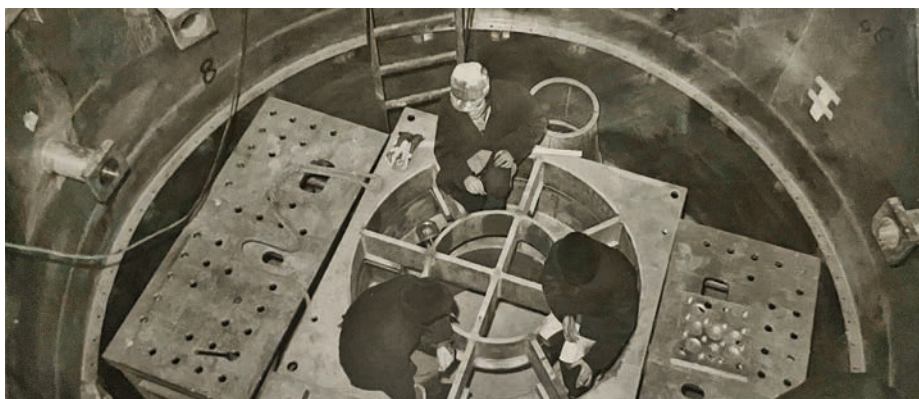
// Prace montażowe w basenie reaktora.
