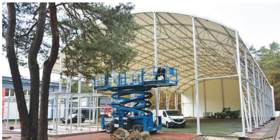
// Budowa hali łukowej na terenie SP nr 2.
