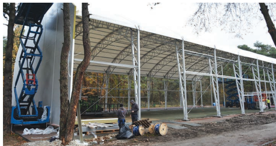
// Hala łukowa w SP nr 2 już pod dachem, stoi też ściana frontowa obiektu sportowego.
