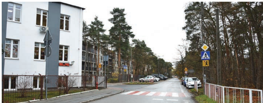
// Opracowanie nowego planu miejscowego umożliwi przebudowę skrzyżowania przy SP nr 4 i budowę miejsc parkingowych
