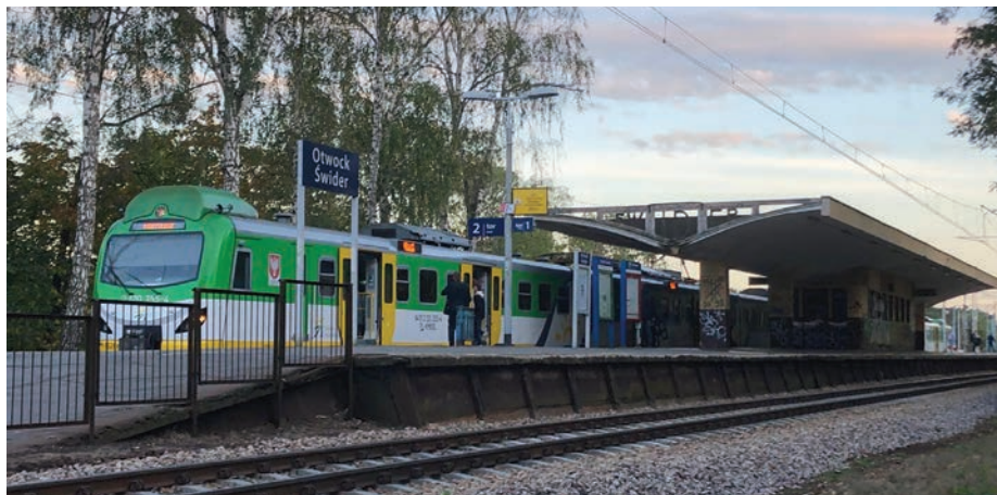
// Stację w Świdrze czeka przebudowa.
