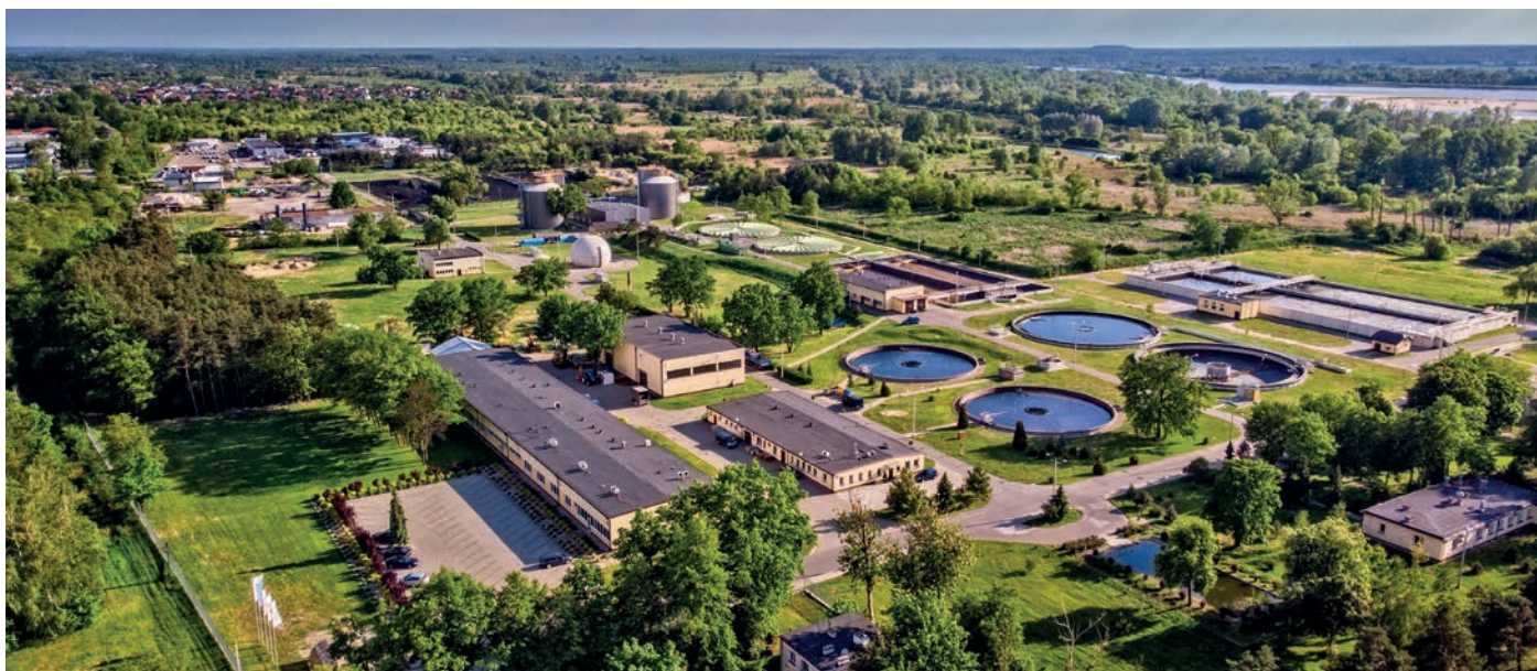
// Otwockie Przedsiębiorstwo Wodociągów i Kanalizacji przy ul. Kraszewskiego.
