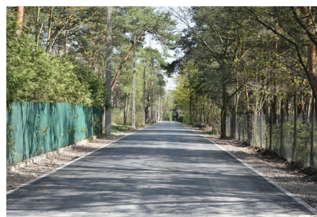
// Ulica Chrobrego z nawierzchnią asfaltową.
