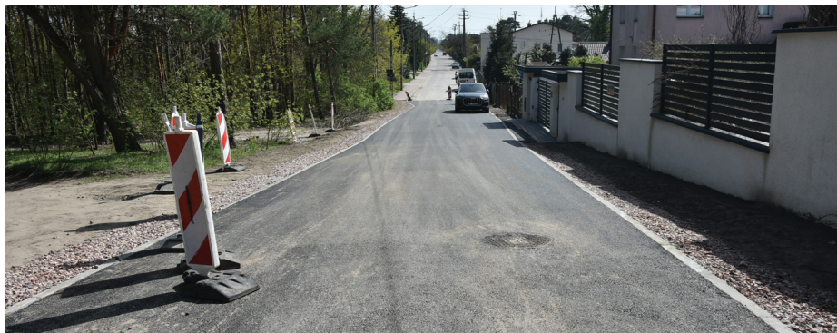
// Brakujący odcinek ul. Okrzei już z asfaltem.
