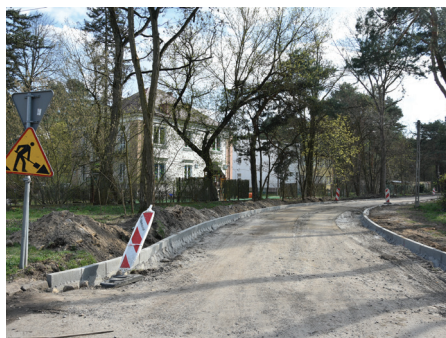
// Ulica 3 Maja w trakcie budowy.
