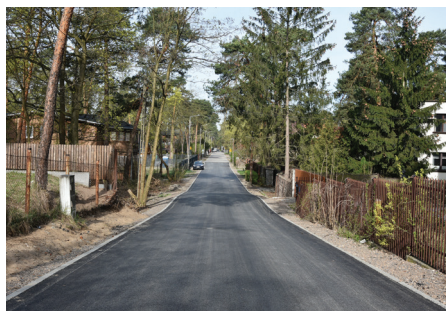
// Ulica Słoneczna w Świdrze już gotowa.
