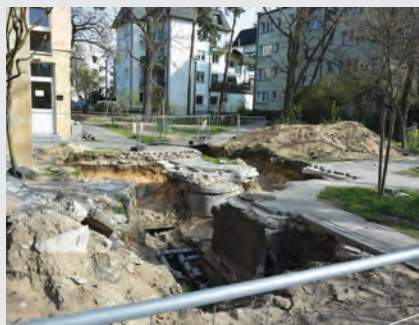
// Wykopy przy ul. Hożej z powodu wymiany sieci ciepłowniczej.
