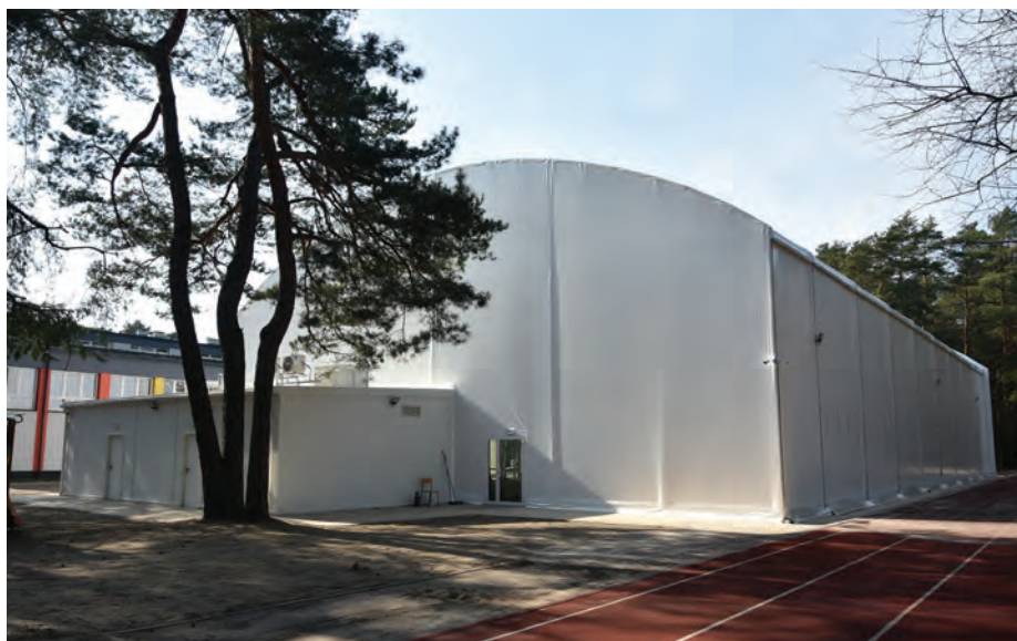
// Widok na szatnię i zaplecze sportowe oraz boczne wejście do hali.
