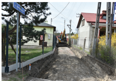
// Ulica Kołobrzaska w budowie.
