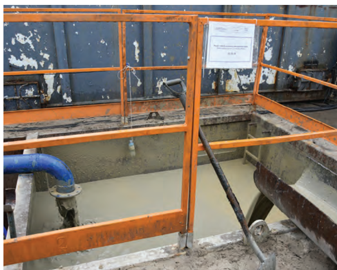
// Płuczki i odpady wiertnicze z odwiertu wody słodkiej.
