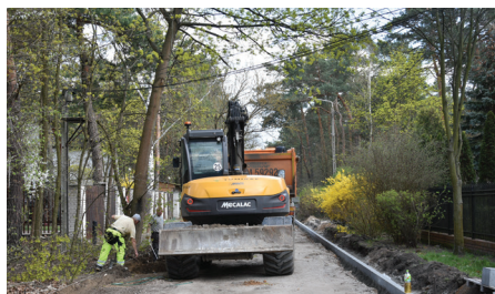
// Prace drogowe na ul. Traugutta.
