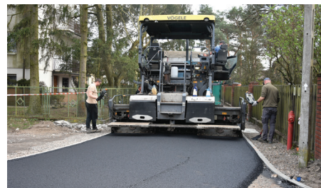
// Układanie asfaltu na ul. Łokietka.
