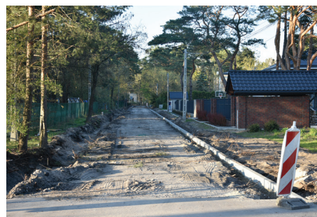
// Ulica Prądyńskiego w budowie.
