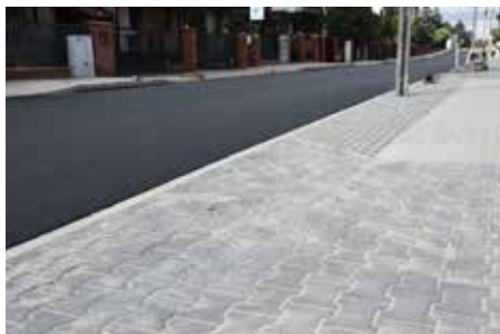
// ul. Okrzei na odcinku od ul. Batorego do ul. im. Hallera.
