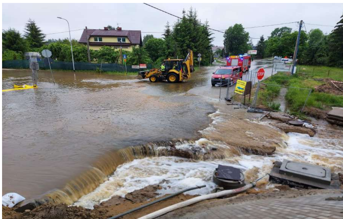
Fotografia 30 – Podtopienia spowodowane obfitym deszczem we wschodniej części Miasta Otwock.
